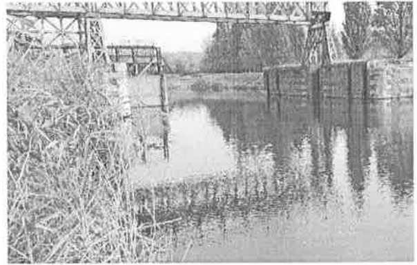
Kanal DTD - kod betonskog mosta
